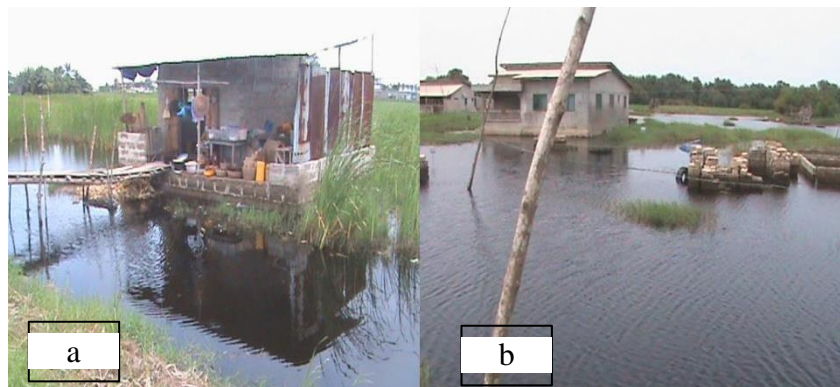
Planche 1: Débordement de l'eau au niveau de la lagune à Togbin daho Prise de vues : F. Lodouhoue, Juillet 2020
