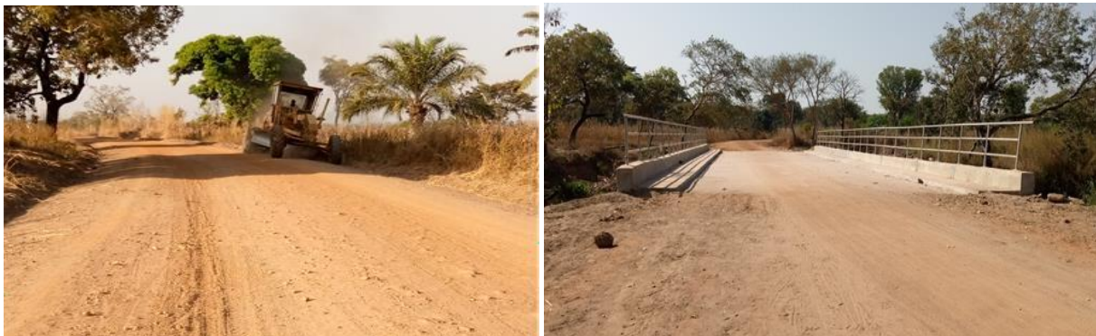
Planche 6 : Réhabilitation de la piste Sotouboua-Titigbé Prise de vues : ADJE, décembre 2020
