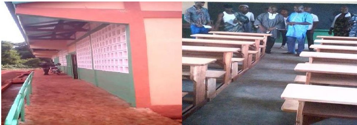
Planche 2 : Bâtiment scolaire réalisé sur le PDCPlus à Pitiyo par AGAIB-RC Source : ONG-ESD (intermédiaire technique), juin 2017
