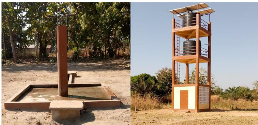
Planche 4 : Forage réalisé à Boa (commune de Sotouboua II) Prise de vues : ADJE, novembre 2020
