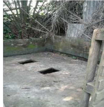
Photo 8 : Trous d'une latrine
