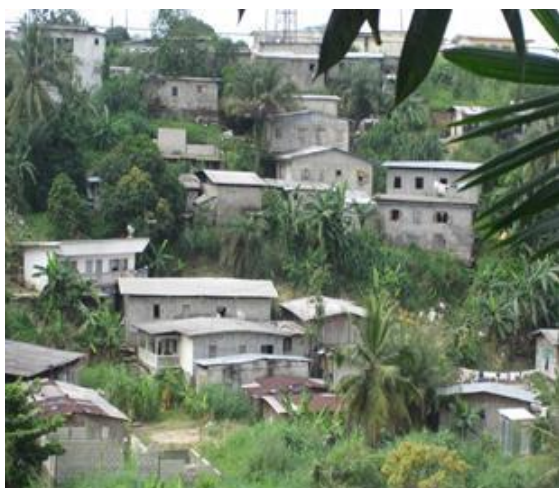
Photo 3 : Habitat précaire dispersé, quartier Plein-Ciel
