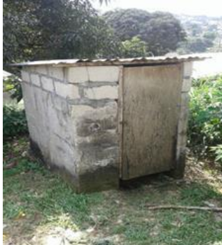
Photo 5 : Type de latrine en dur
