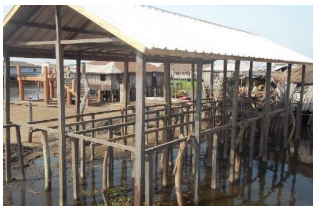
Photo 12 : L'ossature d'une maison en bois sur pilotis (coord. X=433557 ; Y=717775) Prises de vue : I. GUEDEGBE, décembre 2020
