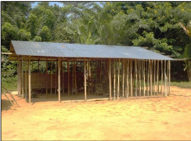
Photo 5 : Charpente d'une maison semi-moderne en construction
