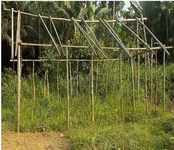
Photo 2 : Charpente d'une maison en construction
