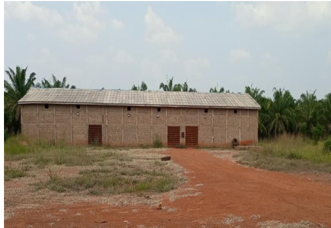
Photo 2 : Magasin en construction à Oké-Ita non loin de la frontière
