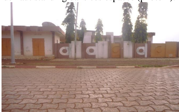
Photo 4 : Habitation moderne construite dans l'espace frontalier à Kétou
