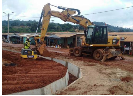
Photo 5 : Pose de caniveau près de la gare de Bongouanou (nos enquêtes, 2019).
