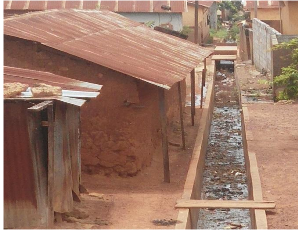
Photo 1 : Les murs et toits de ces maisons au quartier Habitat
