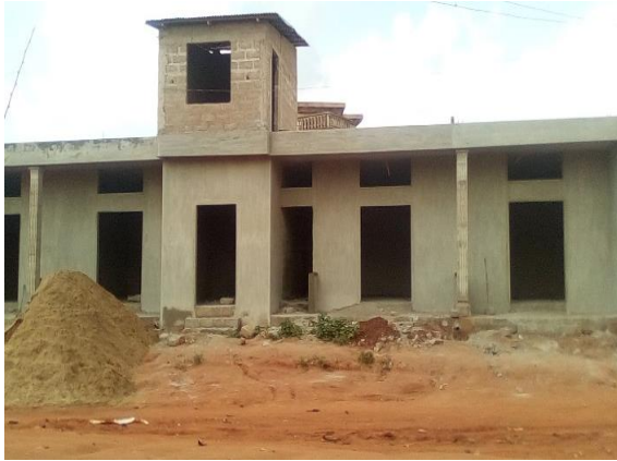
Photo 1 : Une série de boutiques en construction à Tanzoun Prise de vues : Tognon, août 2022
