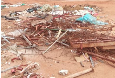
Photo 3 : déchets de papiers et de fers sur un chantier de construction de bâtiment à Akassato Prise de vue : T. E. Fonton, septembre 2023
