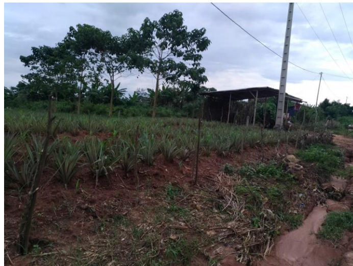
Photo 1 : Vue partielle d'un poteau électrique à Anavié
