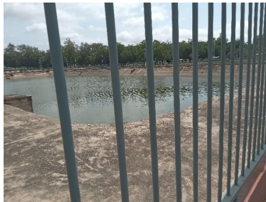
Photo 1 : Bassin d'orage du campus universitaire de Lomé
