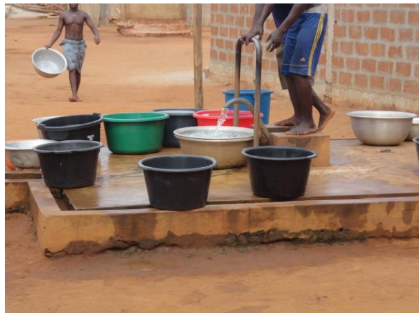
Photo 6 : Forage équipé de Pompe Manuelle à Adjagbo
