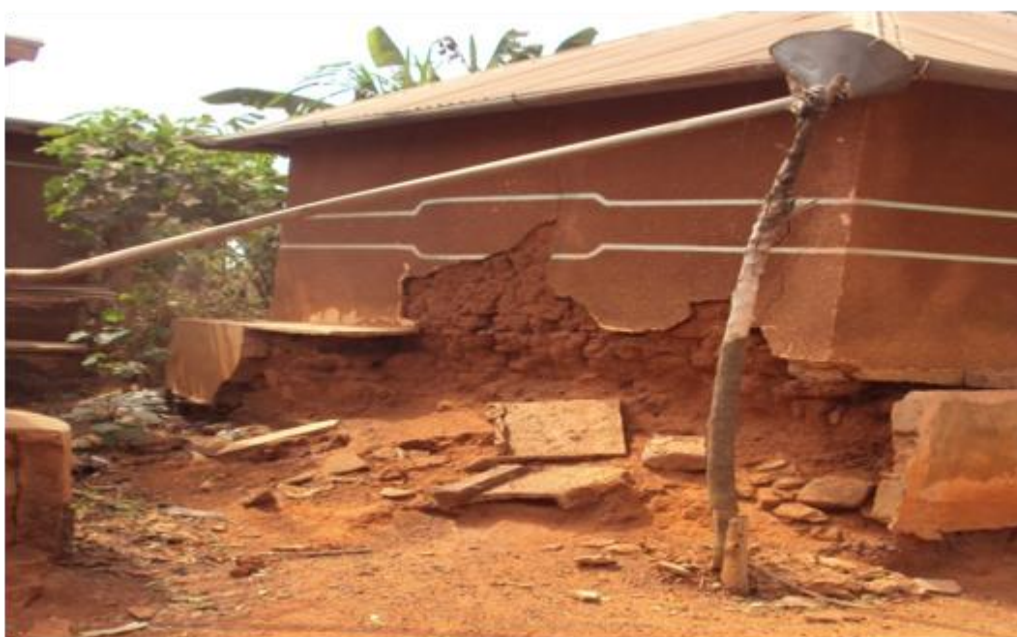
Photo 2 : Déchaussement-effondrement d'un bâtiment à Tannou-Gola
