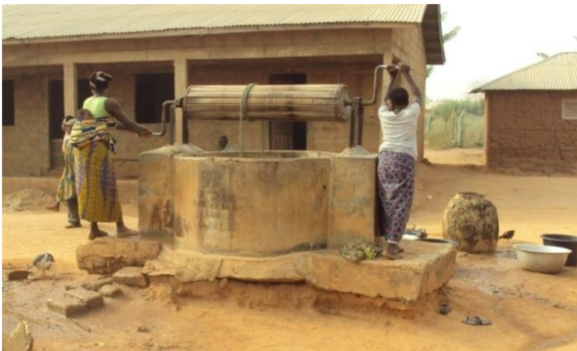
Photo 1 : Déchaussement d'un puits dans l'arrondissement d'Adjido
