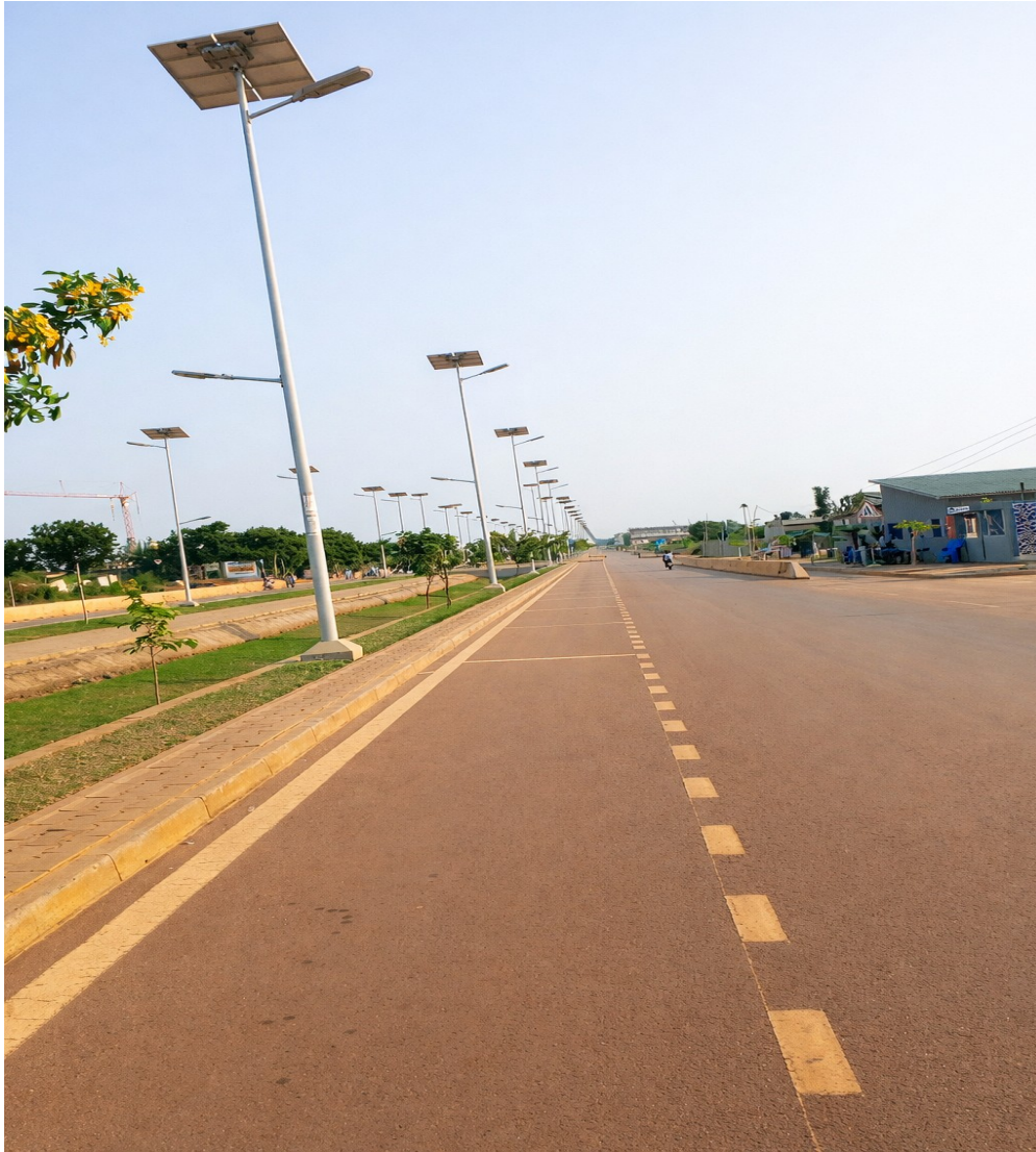
Photo 1 : Voie d'accès à la Cité Ouèdo
