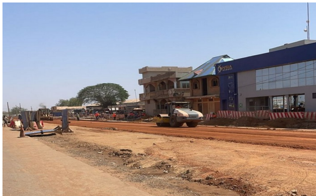
Photo 1 : Travaux d'aménagement de la voie à la devanture de NSIA Banque
