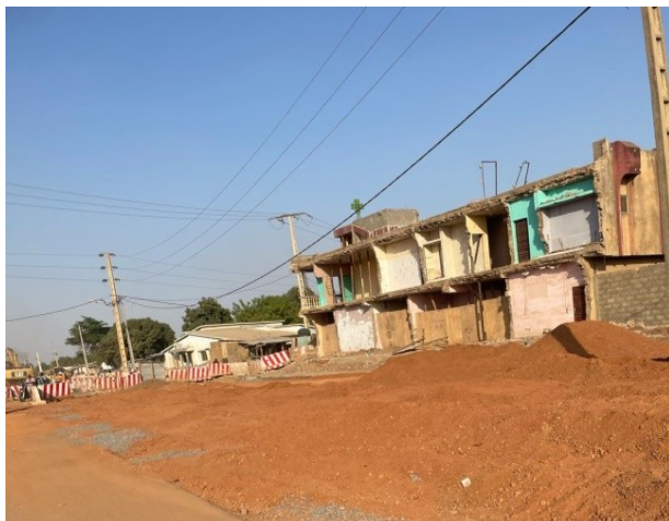
Photo a : Aspect de la pharmacie Nassiara après démolition
